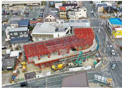
床・コンクリート打設 (12/27撮影)
