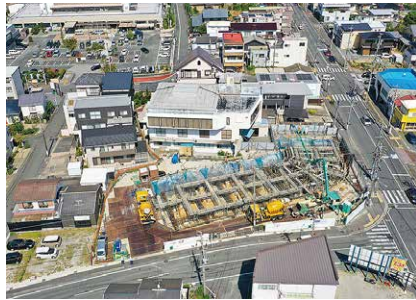
基礎工事 (9/27撮影)
